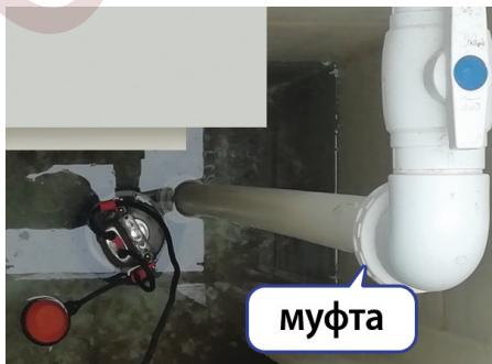
**Обслуживание насосов – эрлифтов, фильтра крупных фракций** заключается в проверке работоспособности. При засорении эрлифта необходимо его поднять на поверхность вместе с фильтром крупных фракций и при помощи мойки высокого давления прочистить. Для этого необходимо отсоединить илопроводы и воздуховоды, ослабив хомутовые с оединения.
