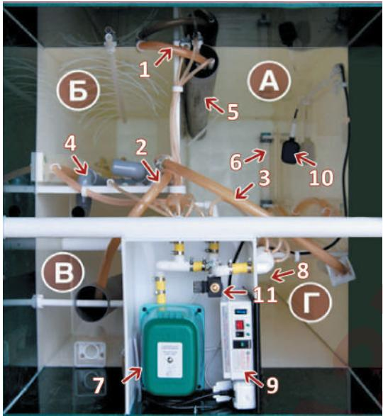
Основной блок (на примере станции «ЮНИЛОС - АСТРА - 5» стандартной комплектации с самотечным водоотведением):
